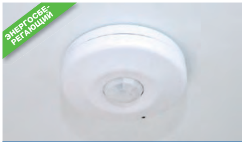
Датчик движения для автоматического включения света
