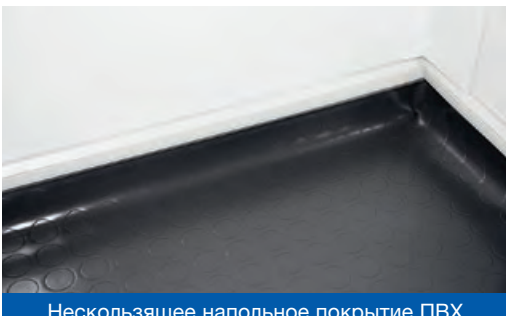
Нескользящее напольное покрытие ПВХ (в форме ванны)
