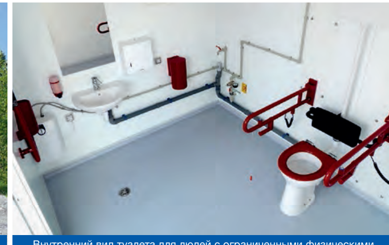
Внутренний вид туалета для людей с ограниченными физическими возможностями согласно DIN 18040-1
