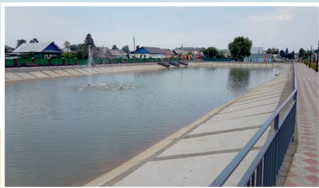
Водоем. Поселок городского типа Алексеевское. Ремонт и гидроизоляция бетонных плит и межплиточных швов.
