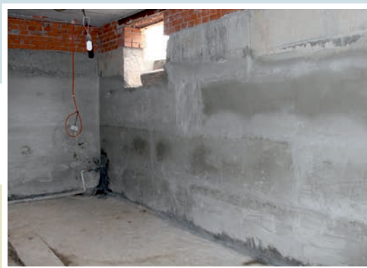
г. Казань. Подвал частного дома. Гидроизоляция.
