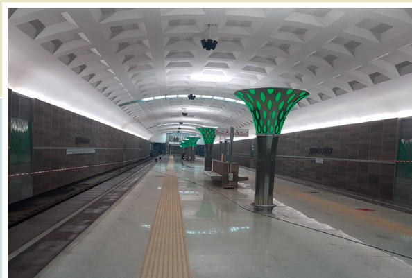
Казанский метрополитен гидроизоляция
