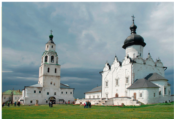
г. Свияжск инъектирование в фундамент из бутового камня
