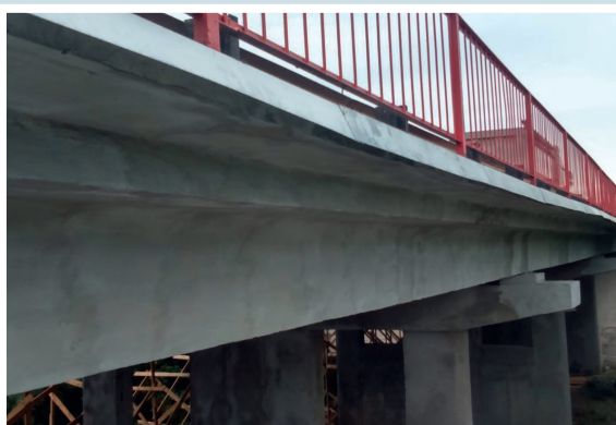
Самарская область, пос.Чагра, ремонт моста
